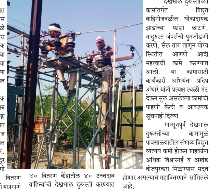
४० वितरण केंद्रातील ४० उच्चदाब वाहिन्यांची देखभाल दुरुस्ती करण्यात आली. देखभाल दुरुस्तीच्या कामांतर्गत विद्युत वाहिनीजवळील धोकादायक झाडांच्या फांद्या छाटणे, नादुरुस्त जंपर्सची पुनर्जडणी करणे, सैल तारा ताणून योग्य स्थितीत आणणे आदी महत्वाची कामे करण्यात आली. या कामासाठी कार्यकारी अभियंता प्रदिप अंधारे यांनी प्रत्यक्ष स्थळी भेट देऊन सुरू असलेल्या कामांची पाहणी केली व आवश्यक सूचनाही दिल्या. मान्सूनपूर्व देखभाल दुरुस्तीच्या कामामुळे पावसाळ्यातील संधांभय विद्युत व्यत्यय कमी होऊन ग्राहकांना अधिक विश्वासार्ह व अखंड वीजपुरवठा मिळण्यास मदत होणार असल्याचे महावितरणने सांगितले आहे.
